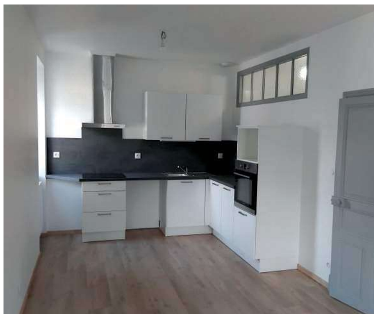
Appartement de l'ancienne Poste rénové par nos agents techniques.
