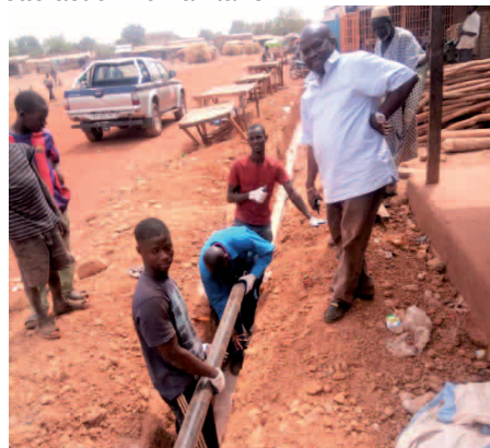
Chantier à Gouana (Mali)
