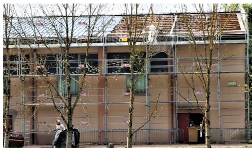
Réfection de la toiture salle R. Almès
