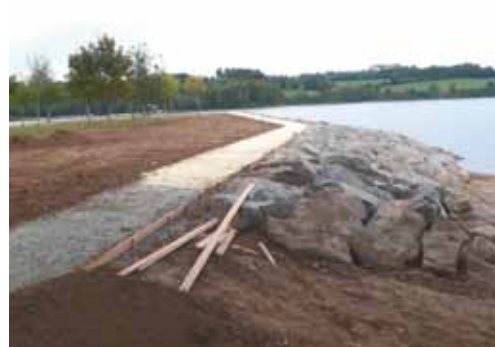
Chantier d'aménagement de la plage
