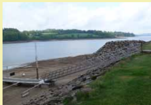
La digue du port a été déplacée
