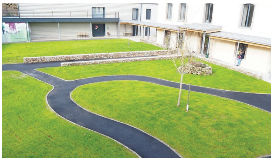
Le jardin en cours d'aménagement
