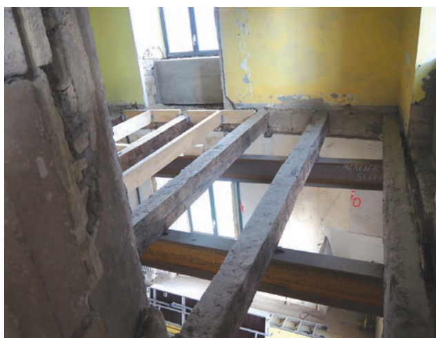
Réfection d'un plancher du couvent au 1er étage
