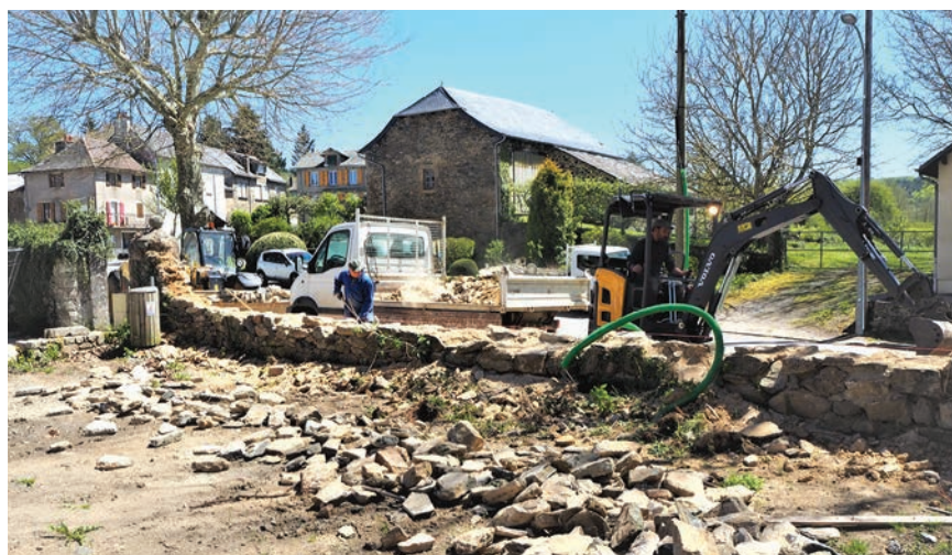
Réfection du mur du jardin
