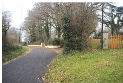
Portion de la route nouvellement goudronnée du Coûtal
