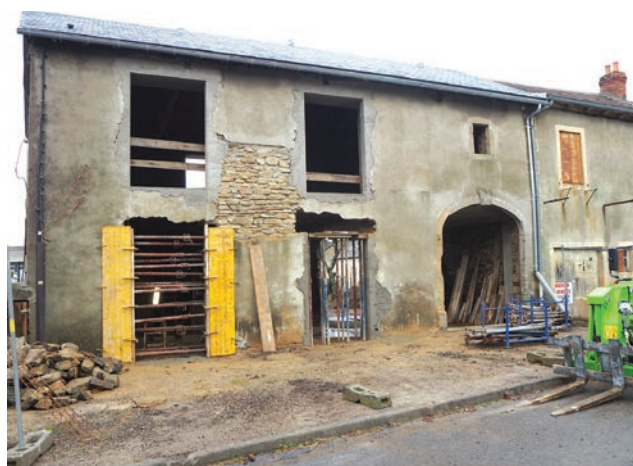
La grange en début de chantier
