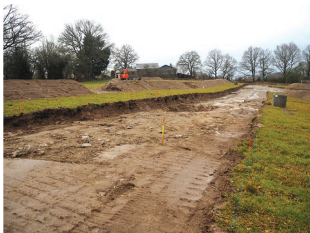
Les premiers travaux...
