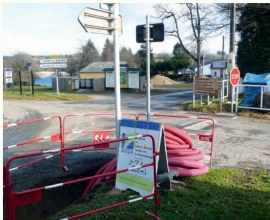
Placés sous la maîtrise d'ouvrage du SIEDA, les travaux confiés à la SLA, basée à Salles-Curan, ont débuté le 9 novembre. Ils consistent à mettre en souterrain l'ensemble des réseaux dits secs : électriques, téléphoniques et éclairage public (des gaines seront posées en réservation dans la perspective de la fibre optique). Les trois tranches, dont deux sont réalisées simultanément, concernent la cité elle-même jusqu'à la plage, le lotissement dit Soulié et l'arrivée en venant d'Arvieu.
