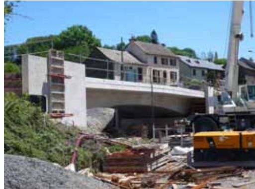
Le nouveau pont sur le Céor
