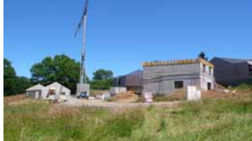
Construction de logements locatifs
